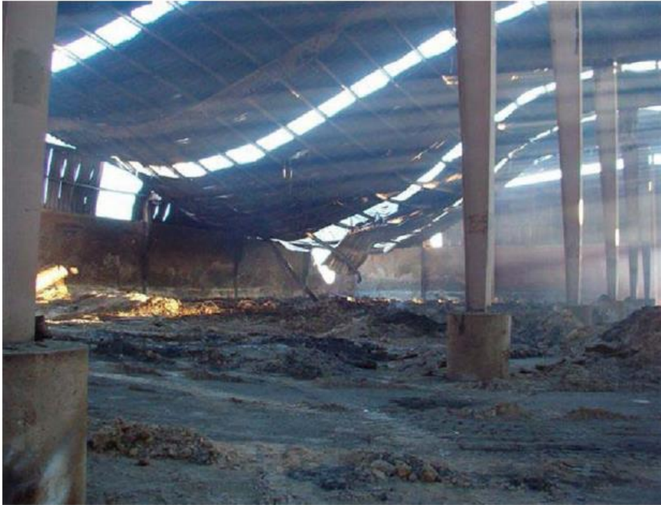
Figure 2-3 Ruine partielle (cas réel et simulation numérique)
